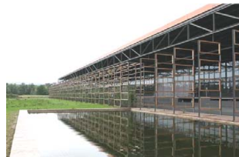
Werkserweiterung Fensterfabrik Baumgartner AG, Hagendorn
